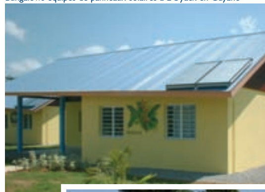
Bungalows équipés de panneaux solaires à L'Oyack en Guyane
